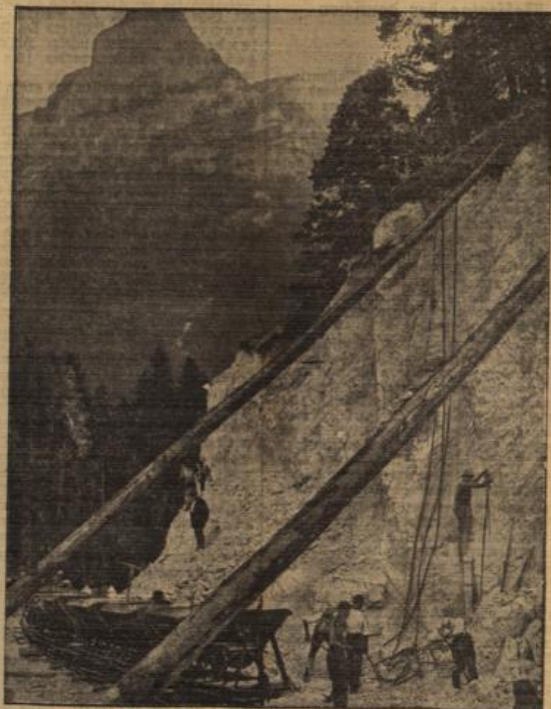
Das Aufbaunwerk: die neue Deutsche Alpenstraße im Sa. Bohrungsarbeiten an der neuen Querspannstraße, die durch die engen Felsentäler des Berchtesgadenlandes führt.
