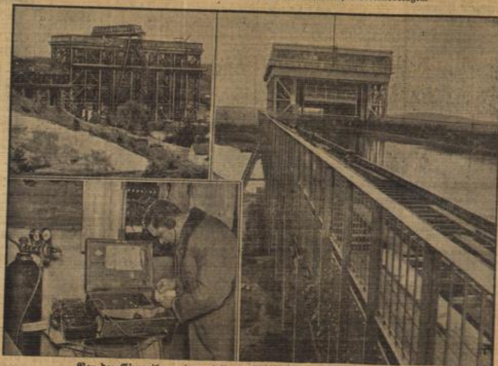
Vor der Einweihung des riesigen Schiffshebewerks bei Niedersim.
