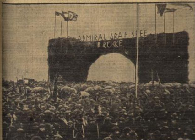
Die gewaltige Menschenmenge während der Feier des ersten Spatenstichs. Unter großer Anteilnahme wurde der erste Spatenstich für den Bau der neuen Rheinbrücke Duisburg-Rheinhausen getan. Die Brücke, die der schönen westdeutschen Großstadt neue Entwicklungsmöglichkeiten gibt, wird den Namen des Grafen Spee, des unvergesslichen Seehelden, tragen.
