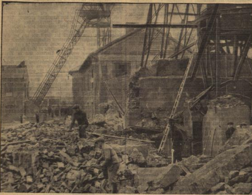
Bild auf die zerstörten Anlagen über Tage.
