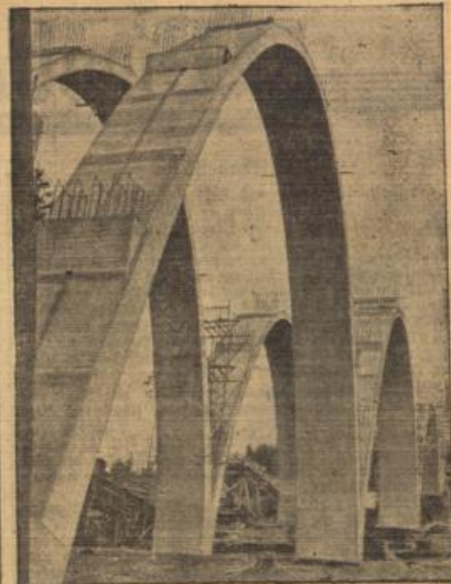
Ein neues Meisterwerk deutscher Brückenbaukunst.
