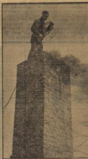
So arbeitet der Handwerker!
