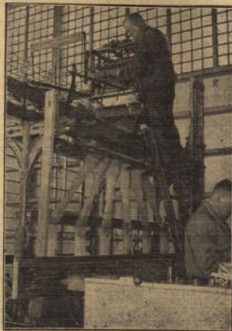
Die Textilfabrik wird ausgebaut.
