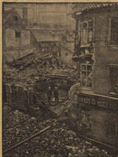
Schweres Einsturzungsland in Jasterburg.
