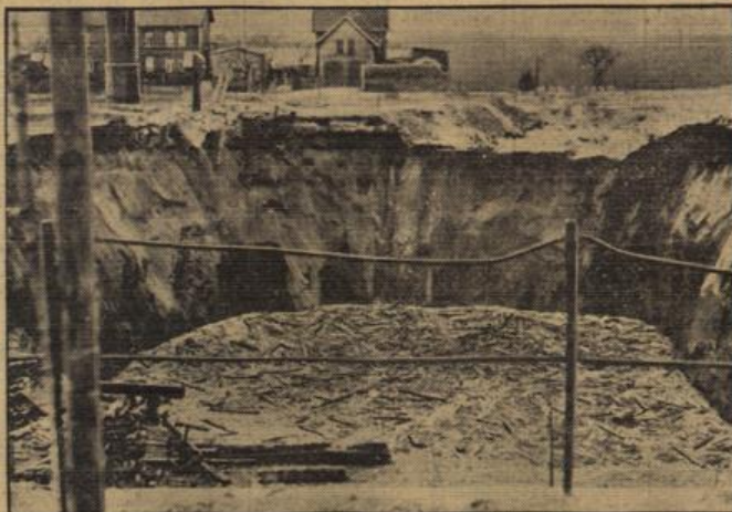
Wassereintruch in stillgelegtem Kalischacht.
