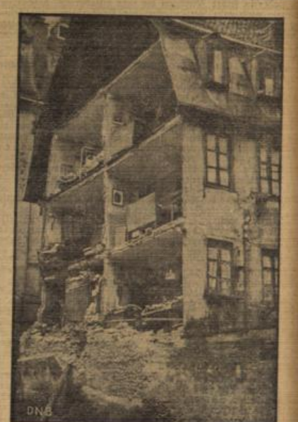
Der Hauseinsturz in der Kaiser Allee. Wie eine Theaterkulisse wirkt das Haus, dessen Seitenwand völlig einstürzte. Wenigen kamen glücklicherweise nicht zu Schaden. (DAB-Feinbildwerkstatt, Photo: Petri.)
