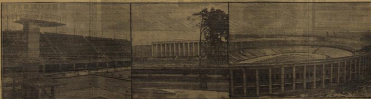
Das Reichsportfeld wächst. Drei Bilder, die vom gegenwärtigen Stand der Bauarbeiten am Reichsportfeld in Berlin, dem Schauplatz der Olympischen Wettkämpfe im Sommer, berichten: (von links) das Schwimmstadion — der Eingang zum Stadion — Blick in das gewaltige Rund des Stadions (Schert-Bilderdruck — M.)
