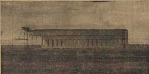
Die 275 Meter lange Luftschiffhalle vor der Vollendung.
