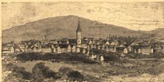
Ansicht von Schorndorf.
