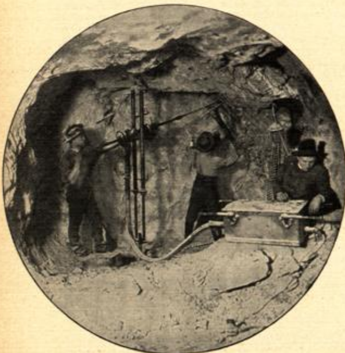
Durch Elektrizität betriebene Bohrmaschine in einer Tiefe von 500 Meter.
