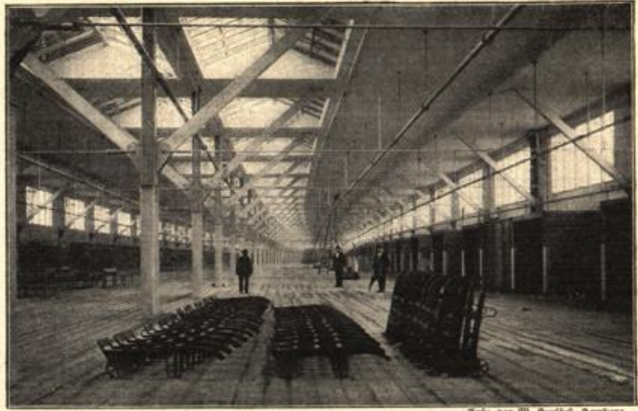
Der neue Südfrachtschuppen in Hamburg. Innenansicht.
