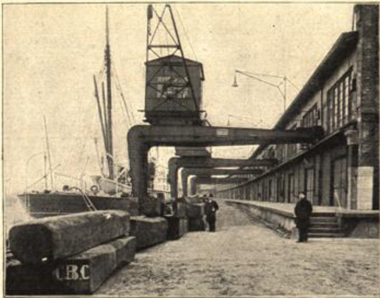
Der neue Südfrachtschuppen in Hamburg. Außenansicht.
