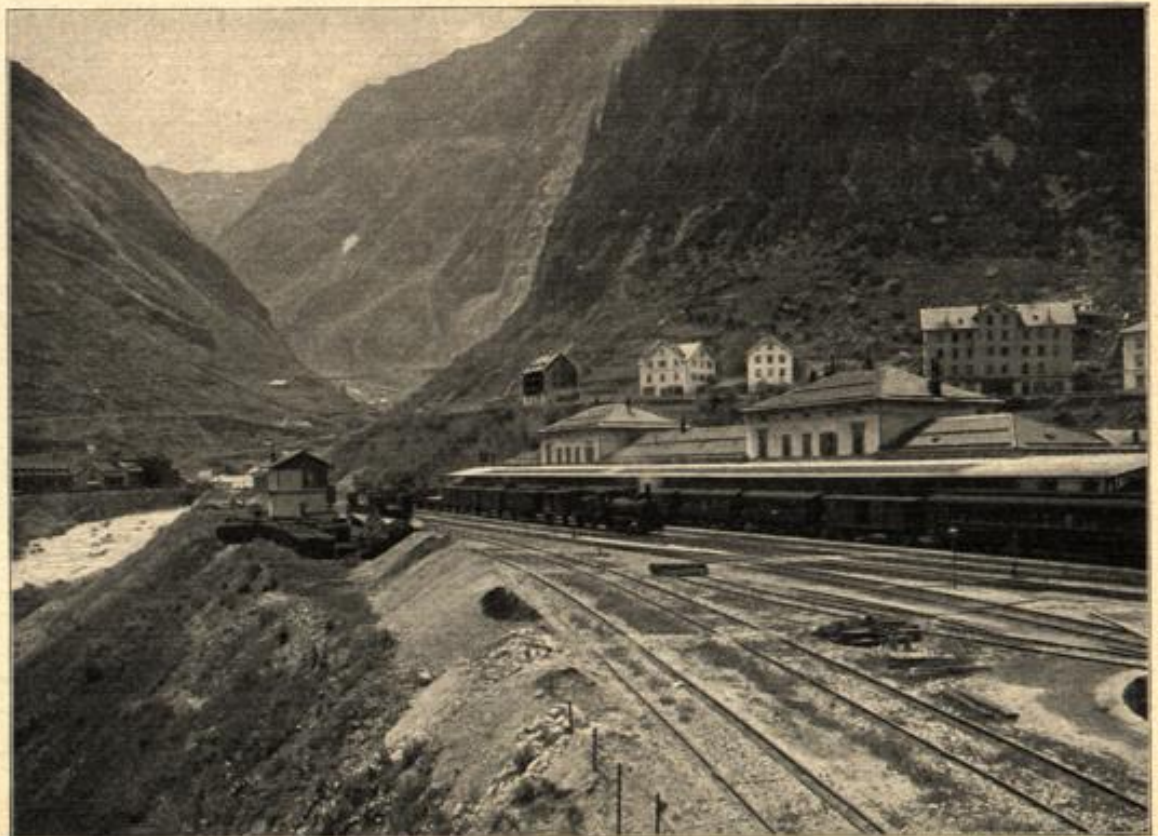
Bahnhof in Göschenen mit Tunnelzugang (Gotthardtunnel).
