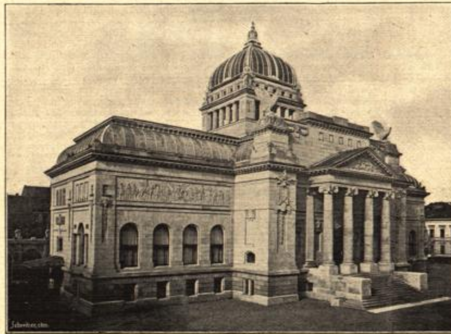
Die Ruhmeshalle in Barmen. Erbaut von Erdmann Hartig.
