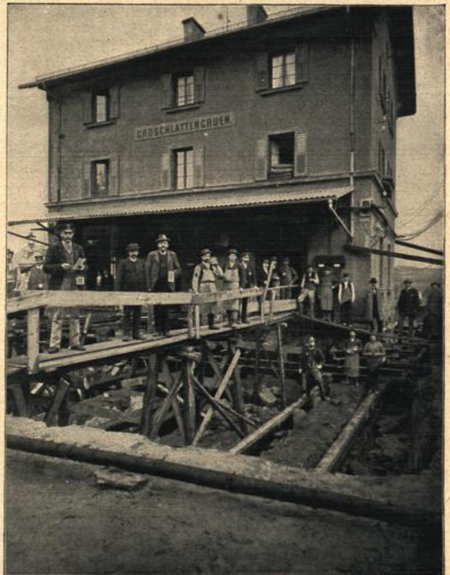
Die Verchiebung des Bahnhofgebäudes von Großslattengrün.
