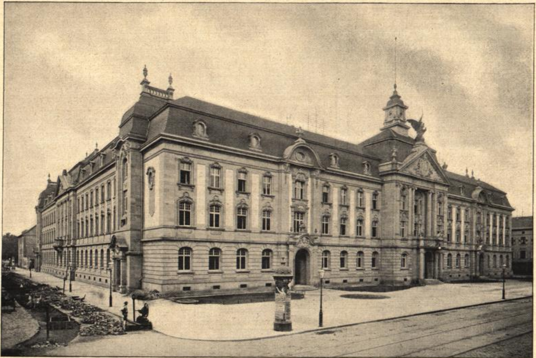
Gesamtansicht von der Kaiserstraße.
