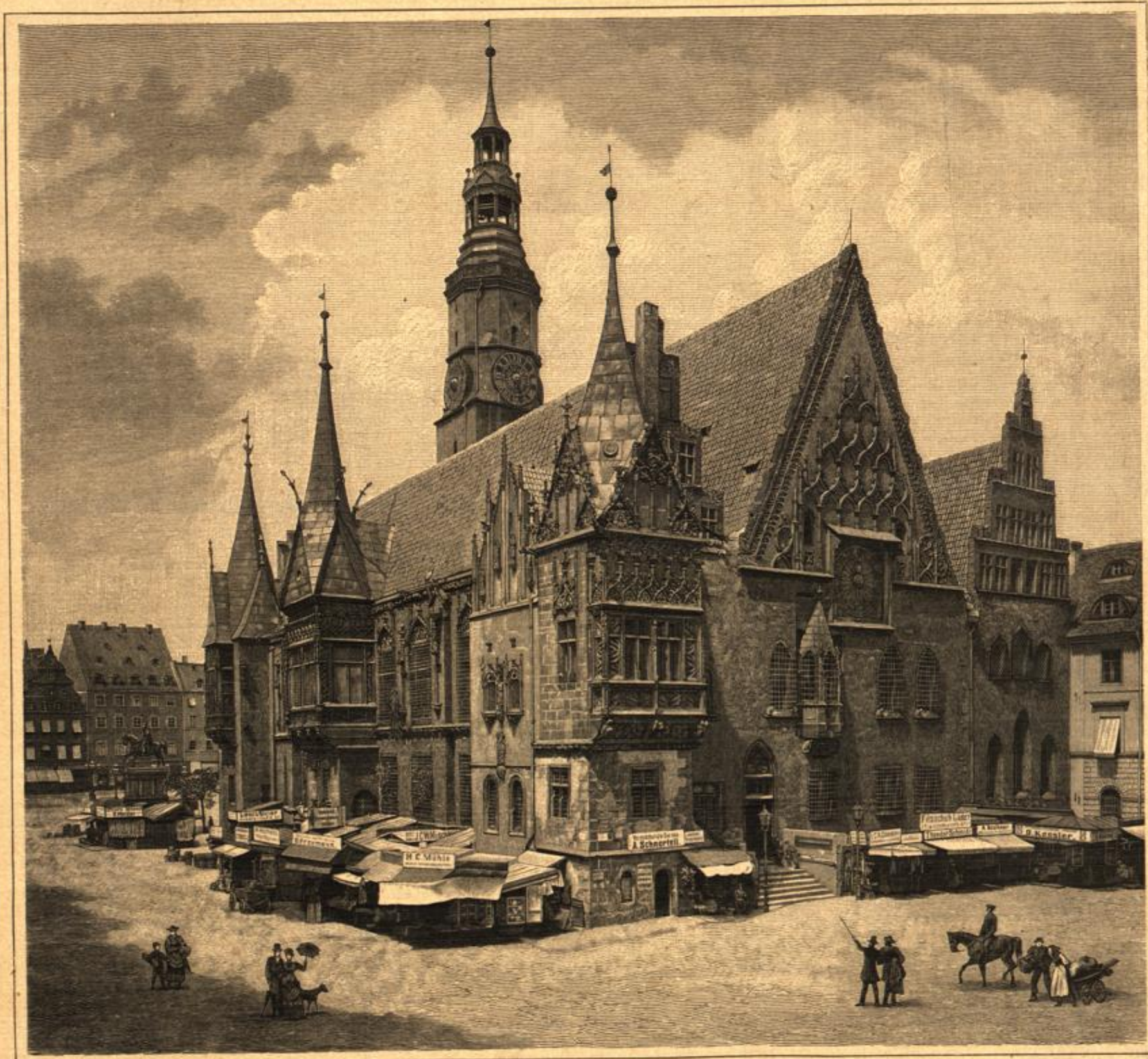
Das Rathaus in Breslau. Nach einer Photographie von Ed. van Delden in Breslau. (S. 355.)
