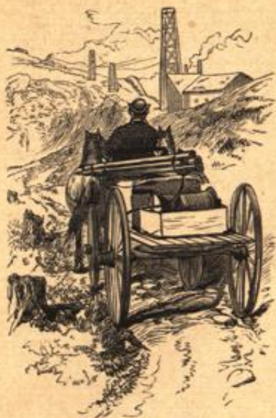
Der Wagen mit der Sprengmaschine.
