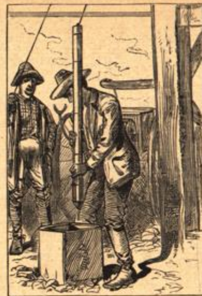
Das Hinablassen der Sprengpatrone.
