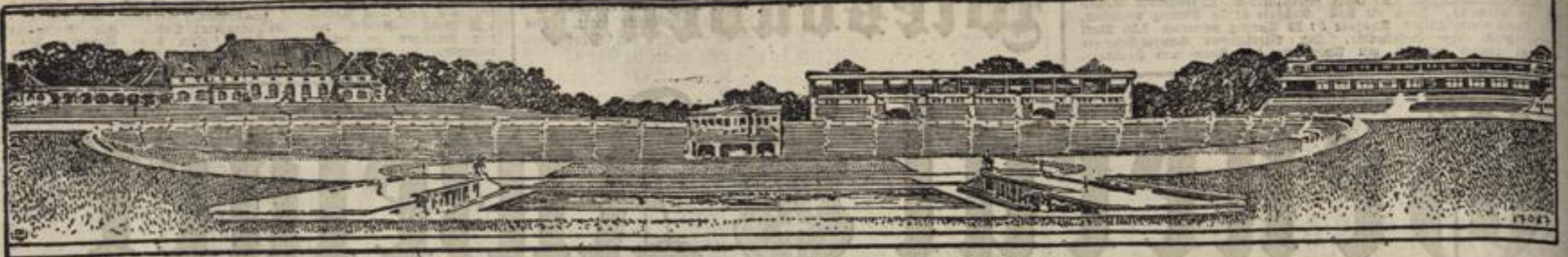
Das Stadion, das im Grunewald bei Berlin gebaut wird.
