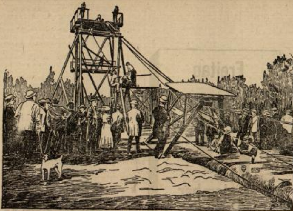
Auf dem neuen Flugfeld Mars am Bahnhof Vort bei Belg. Die Seilbahn, die von einem Turm ausgeht und den Flugmaschinen die zum Ausflug nötige Anspannung gibt.
