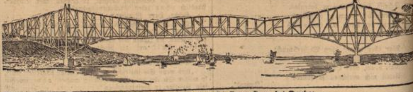
Die Eisenbahnbrücke über den St. Lorenzstrom bei Quebec.
