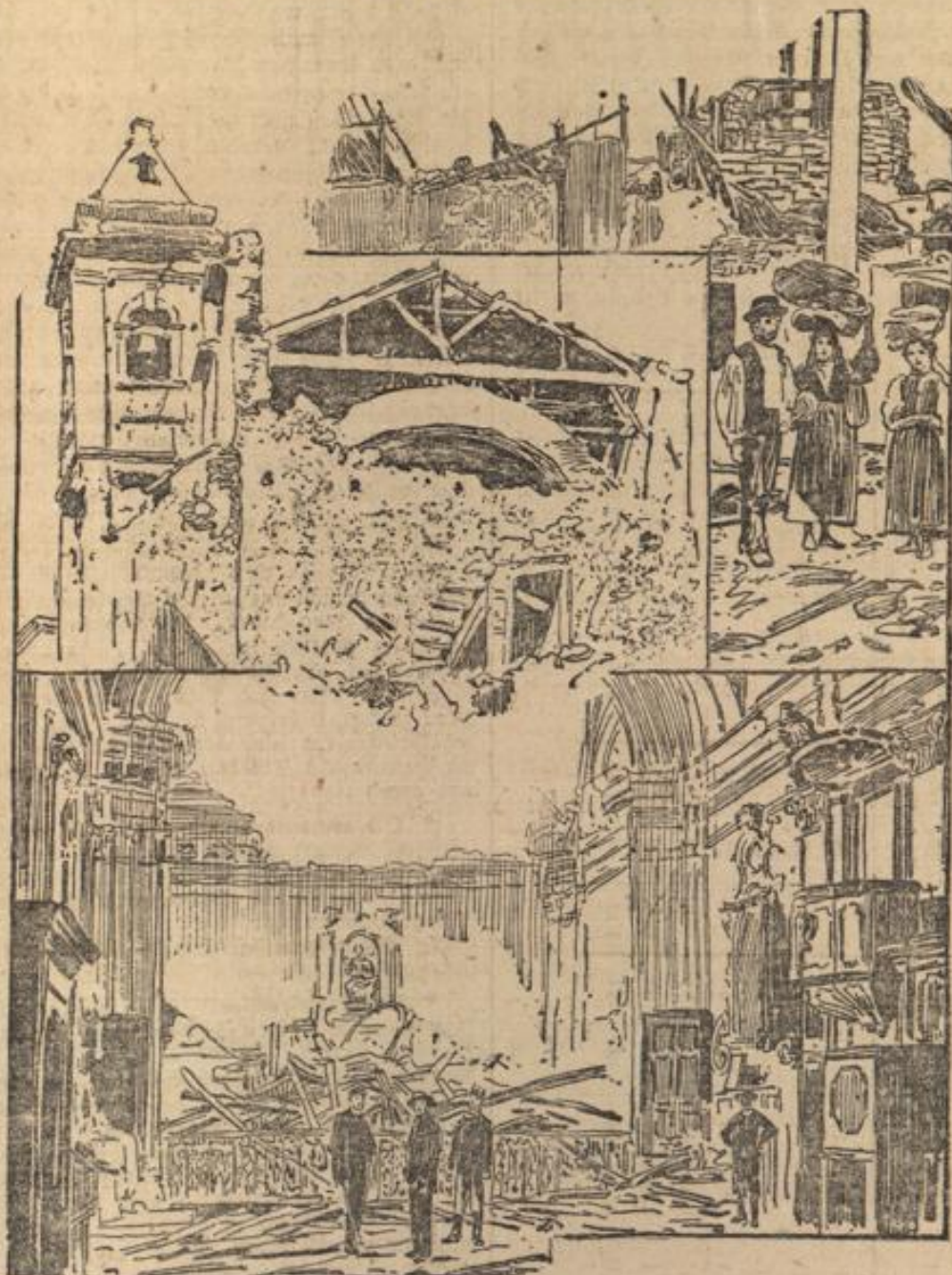
Trümmerstätten nach dem Erdbeben in Kalabrien.
