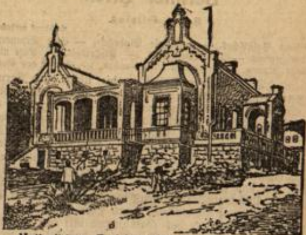
Kaiserliches Gerichtsgebäude in Windhuk.
