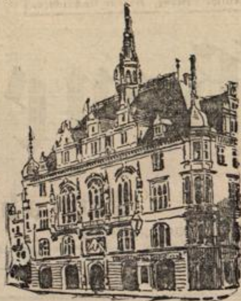
Neues Rathhaus in Halle.
