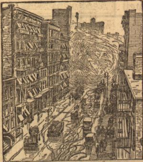
Großfeuer in New York. Bekämpfung des Brandes mittels ungeheurer Wassermengen.
