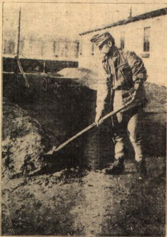
Kerr.-ung. Kriegsbeschädigter verrichtet Erdbarbeiten vermittels Armprothese. Berl. Ill.-Ges. m. b. H. Aufnahme des Hs. Erbdes Uffg.
