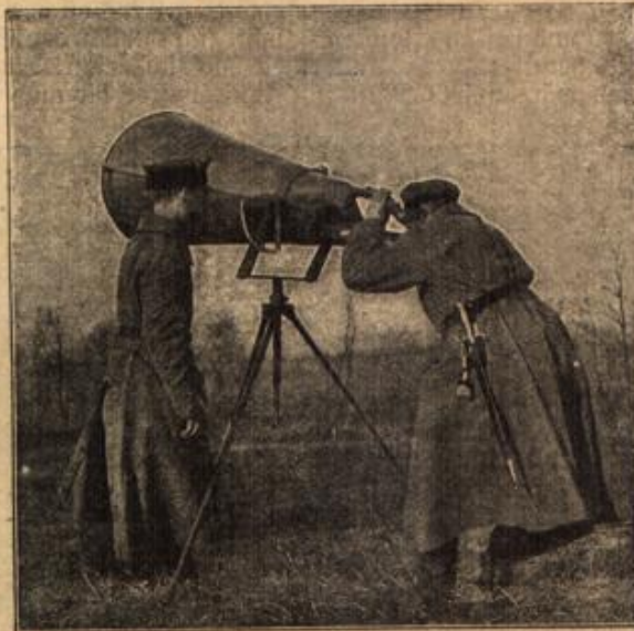
Sorohapparat, mit dem die Annäherungsrichtung feindlicher Flugzeuge festgestellt wird.
