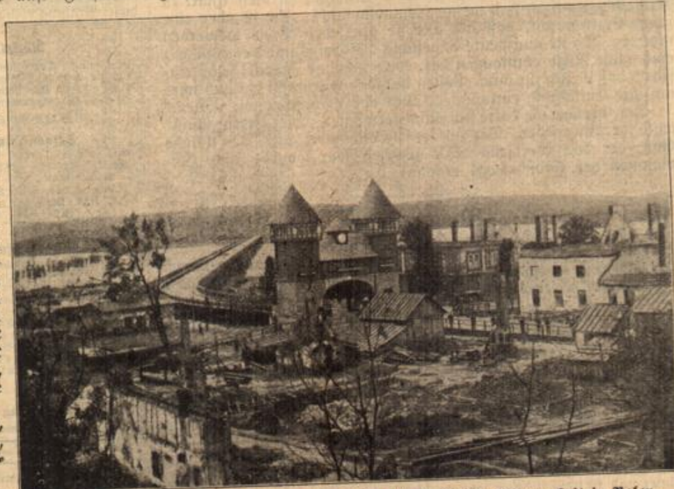
Die neue Weichselbrücke bei Pulawy; ein Werk österr.-ungar. Kunsturarbeit in Polen.
