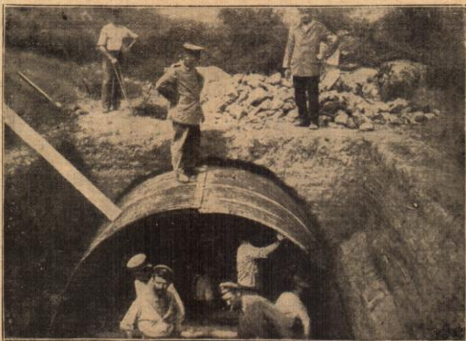
Bau eines bombensicheren Unterstandes in Mazedonien.
