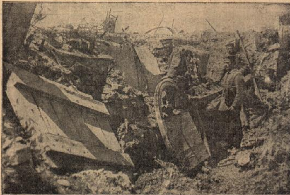
Zerschossene betonierte Truppenunterstände an der Somme. (Zensiert Generalstab.)
