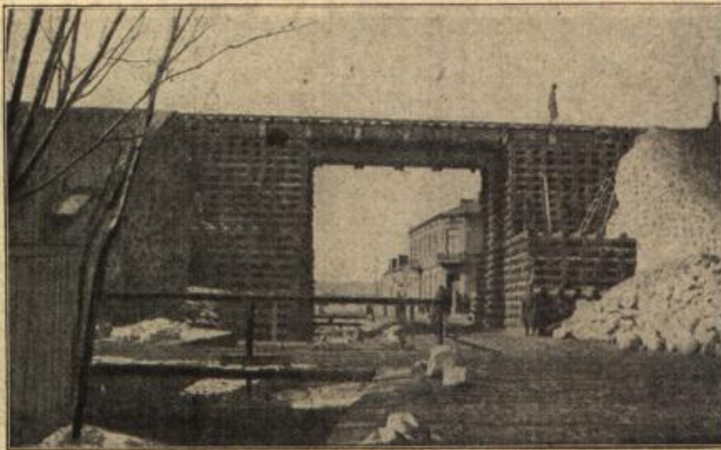
Notbrückenbau aus Bahnschwellen.
