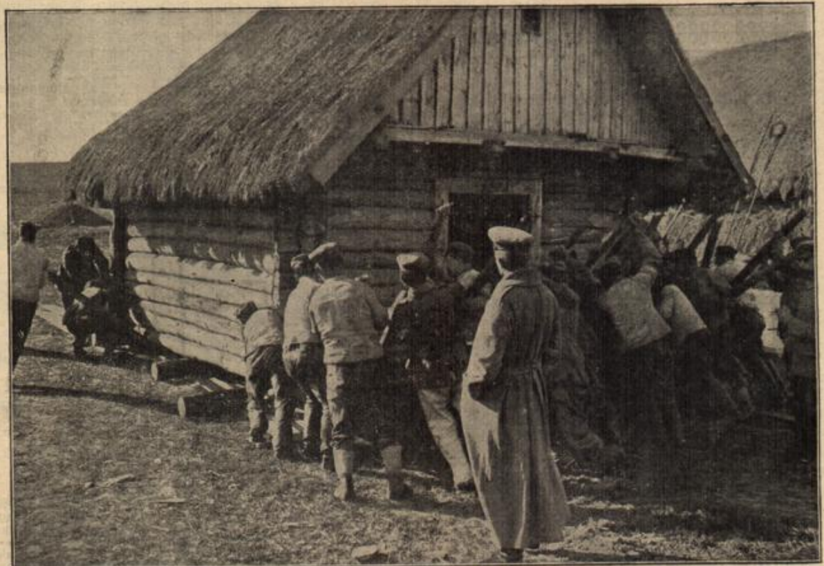
Deutsche Soldaten in Rußland befördern ein vollständiges Holzhaus von einem gefährdeten Platze an eine gesicherte Stellung. Phot. Groß.
