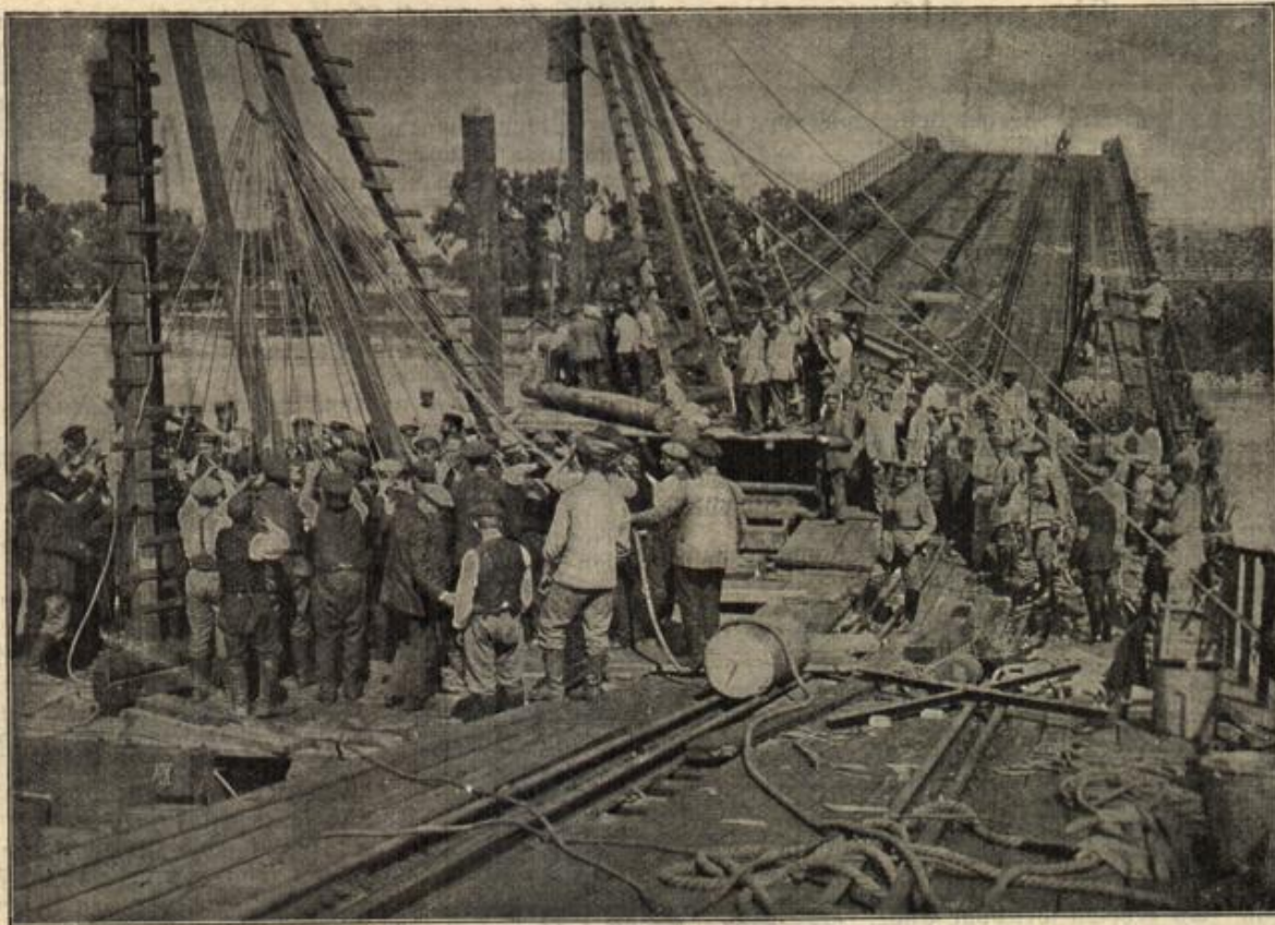
Deutsche Pioniere bei der Zustandsetzung der von den Russen gesprengten Weichselbrücken in Warschau. (Mit Text.) Phot. R. Sennede.
