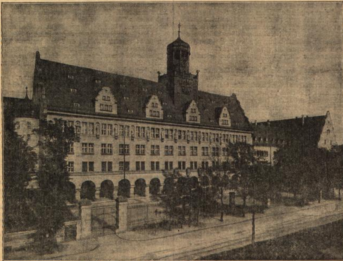
Das neue Zentraljustizgebäude in Nürnberg. (Mit Text.)
