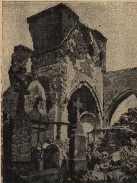
Überreste des Turmes der durch englische Granaten zerstörten Kirche in Yorgies (franz. Flandern).
