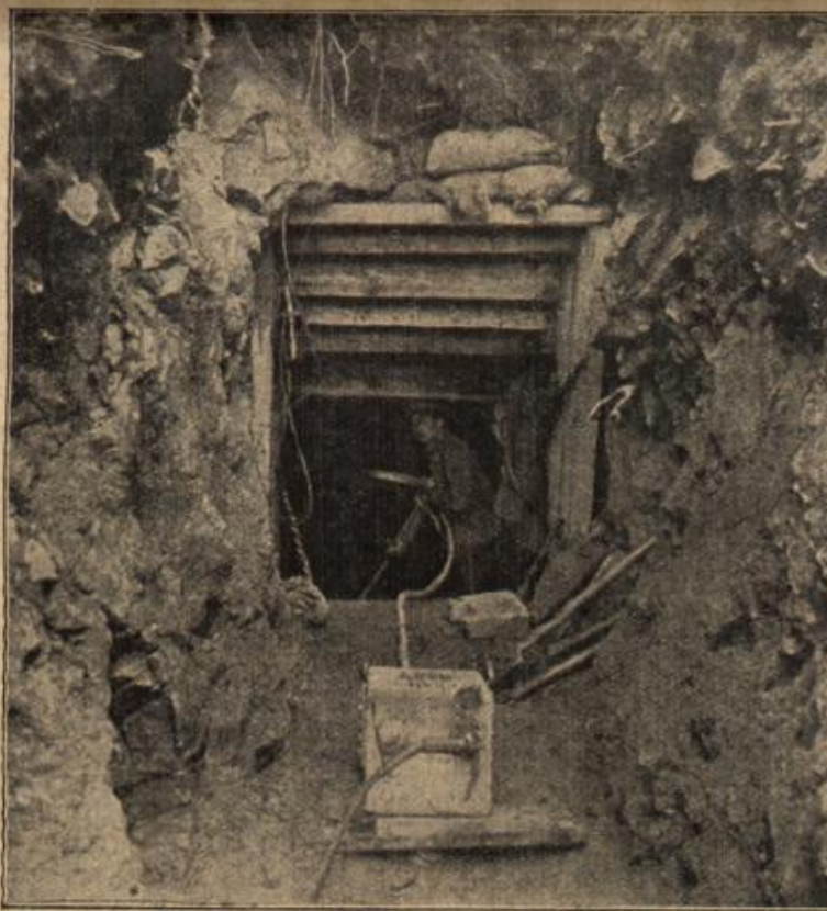
Von den Minenlampen in den Bogenen: Elektrischer Gesteinsbohrer in einem Felsen. Phot. Wipperling. (Zensiert Generalstab.)
