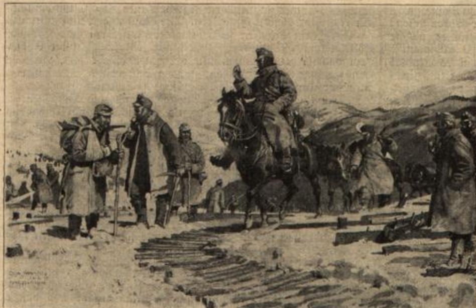
Herstellung von Anknappdämmen durch österreichisch-ungarische Arbeitsabteilungen.
