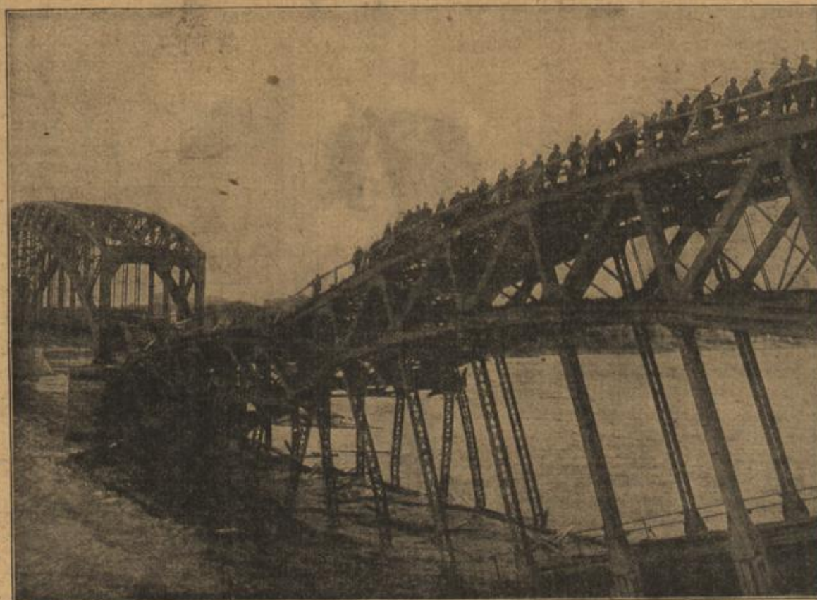
Deutsche Truppen beim Passieren der Eisenbahnbrücke bei Riga, die von den Russen vor ihrem Rückzug gesprengt und von den deutschen Pionieren sofort wieder zu einer Holzbrücke ausgebaut wurde. Phot. Bild- und Filmamt.
