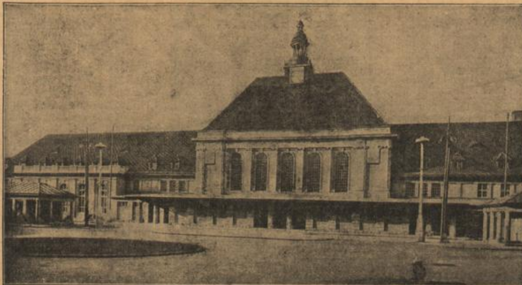
Der kürzlich fertiggestellte neue Bahnhof in Görlitz.
