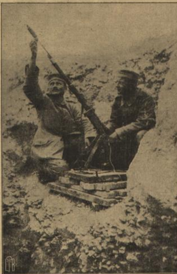
In die Wand eines deutschen Schützengrabens eingebaute Gewehrgranate beim Feuern.
