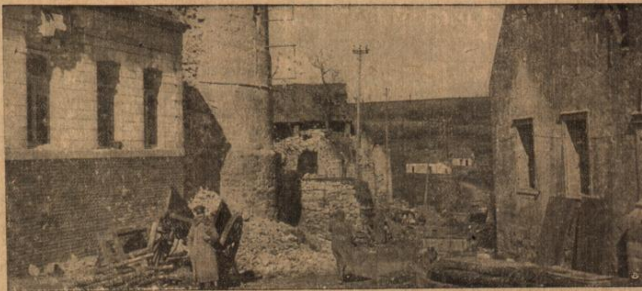
Zusammengeschossene Straße in Carency.
