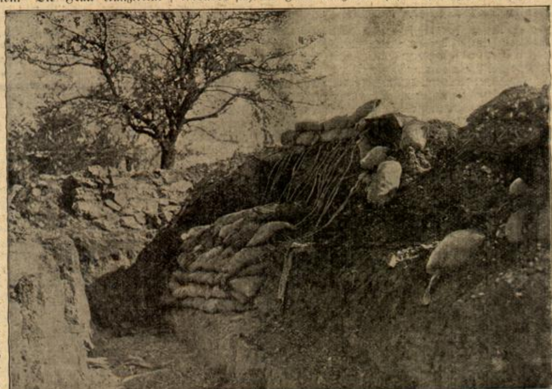
Kämpfer Graben mit eingebauter Gasstation. Phot. Conrad Hünich, Berlin.
