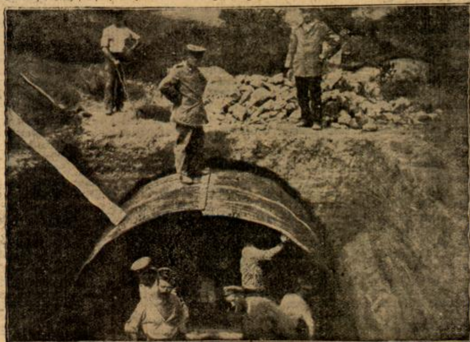
Bau eines bombensicheren Unterstandes in Mazedonien.
