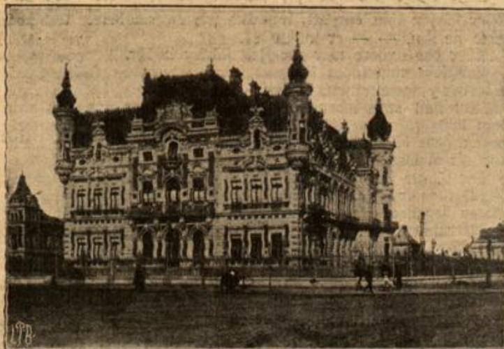
Das Ministerium des Äußern.
