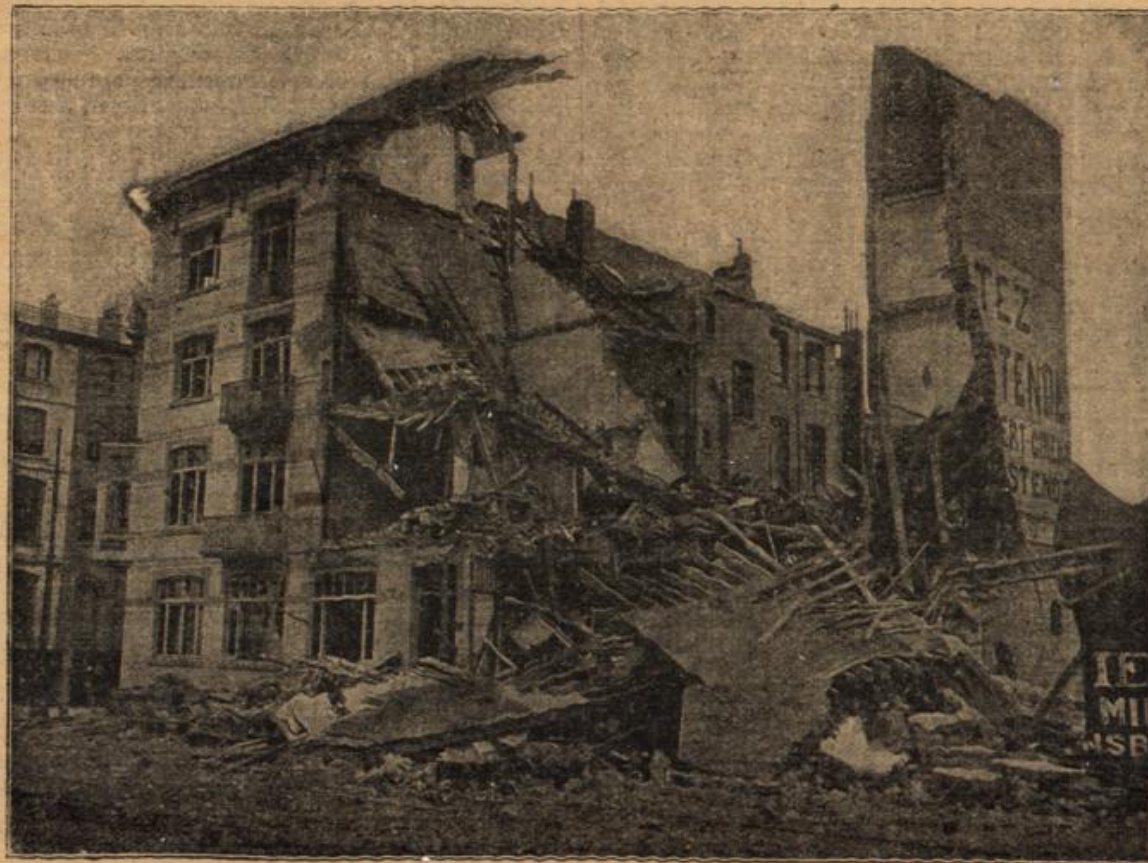
Die Zerstörung eines Hauses durch die Engländer. (Mit Text.)
