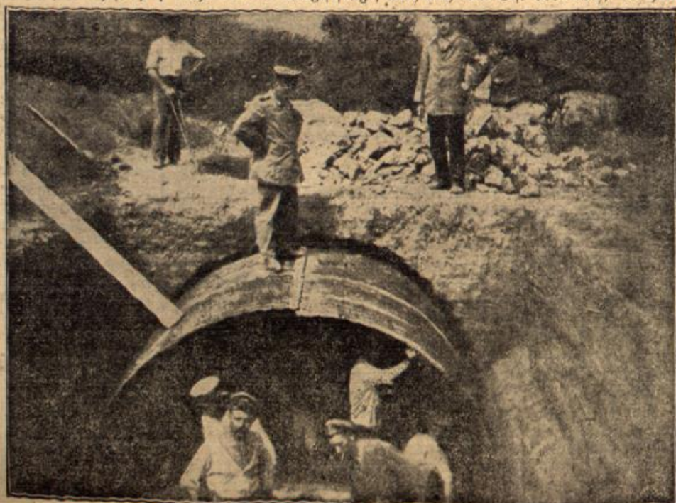
Bau eines bombensicheren Unterstandes in Mazedonien.
