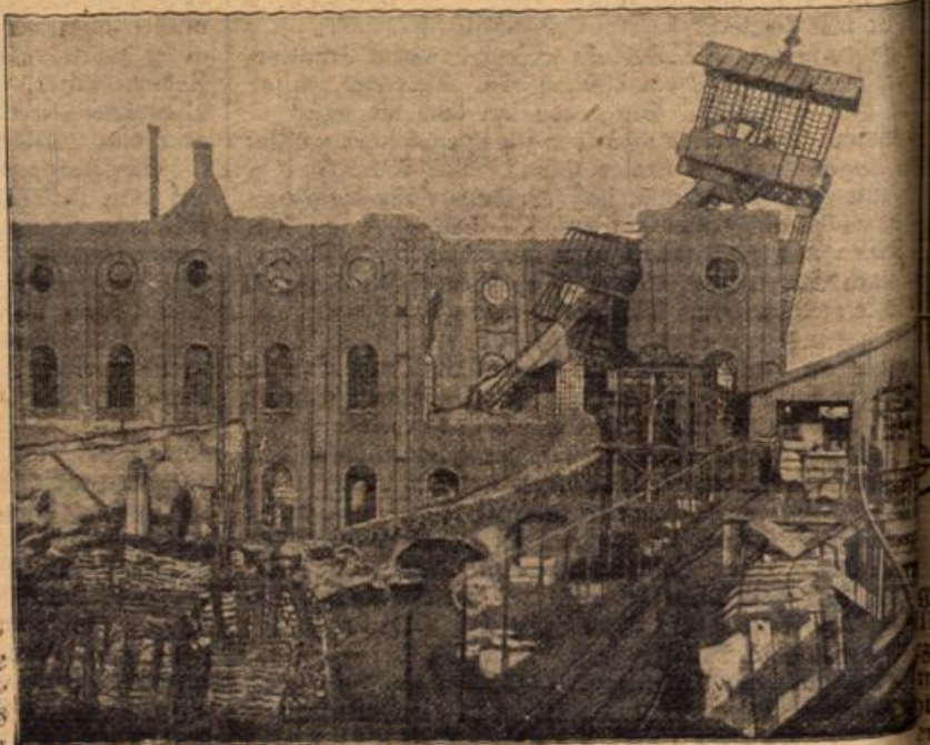
Eine vollständig zerstörte Kohlengrube bei Lens.
