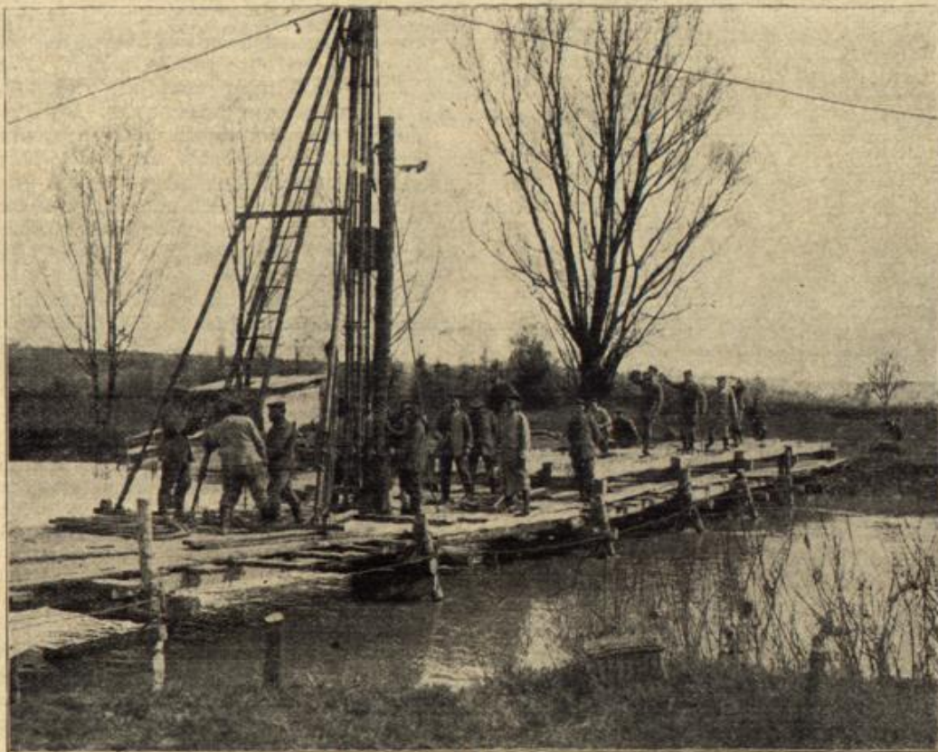
Pioniere beim Brückenbau.
