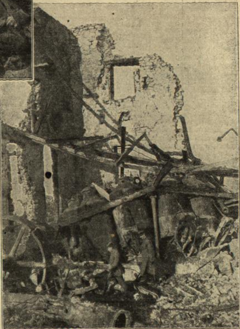
Von den Kämpfen an der Somme: Das von den Franzosen vollständig zusammengeschossene Maschinenhaus einer Zuckersfabrik.
